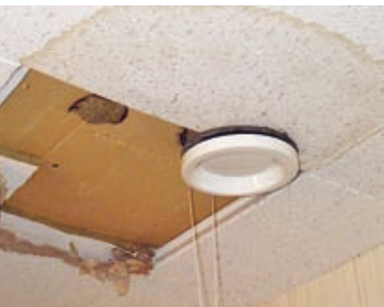
TYDLIGT TECKEN. Fuktbläckar i taket är ett säkert varningstecken på att något är fel.
