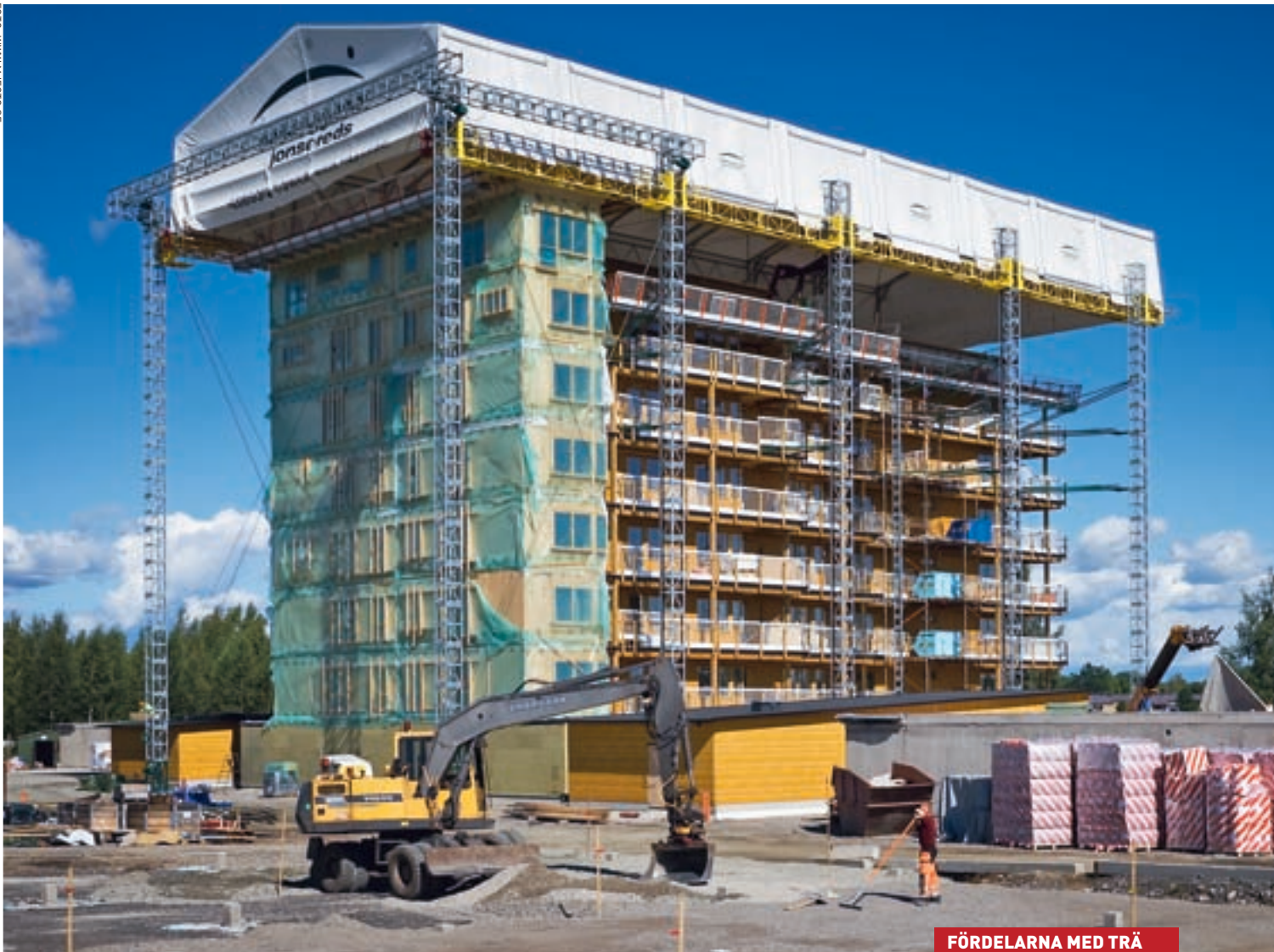
Konstruktionen måste vara täckt under hela byggtiden. Vädskydd som höjs i takt med att huset reses är därför en förutsättning när man bygger i trä. Bilden visar bygget av kvarteret Limnologen vid Välle Broar i Växjö.
