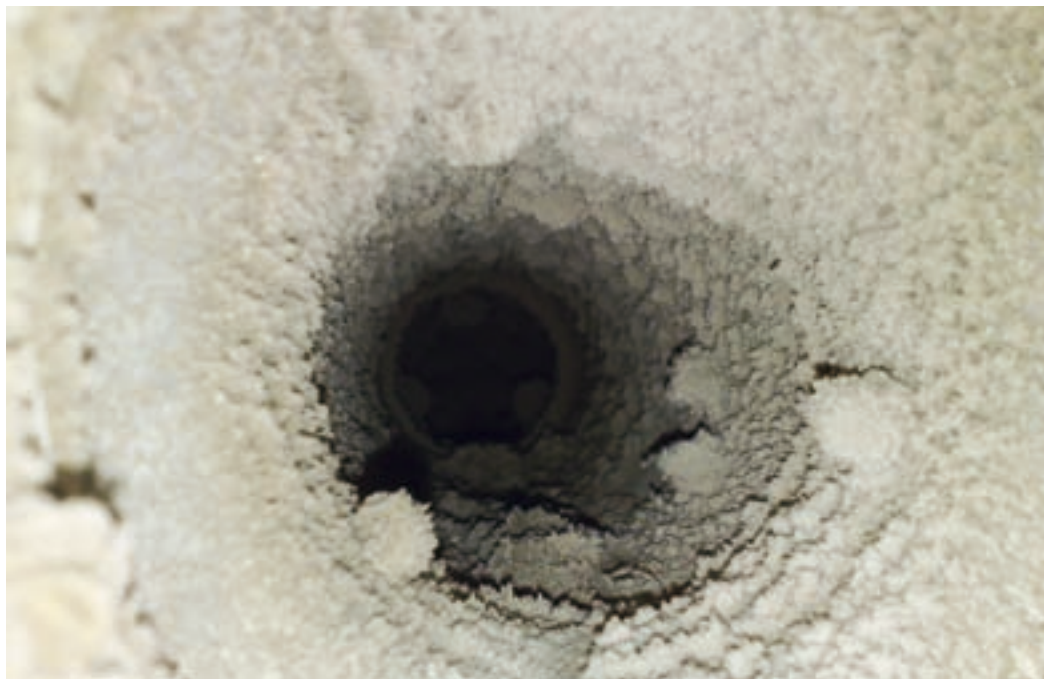
DAMMTÄCKE. En dåligt rensad frånluftskanal försämrar hela ventilationssystemets funktion med sämre inomhusluft som följd.
