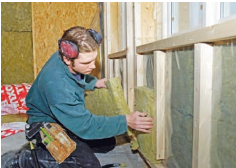
Isolering av yttervägg med inflyttad ångspärr som skapar installationskikt.
