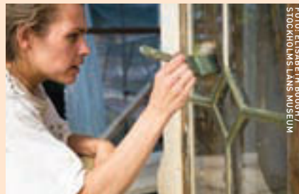
Renovering av fönsterbågar. Många gamla fönster består av kärnved, som klarar fukt bra.
