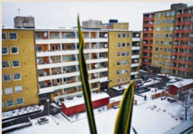
Herrgården är en del av stadsdelen Rosengård i Malmö. Husen i området är byggda i slutet av 1960-talet.
