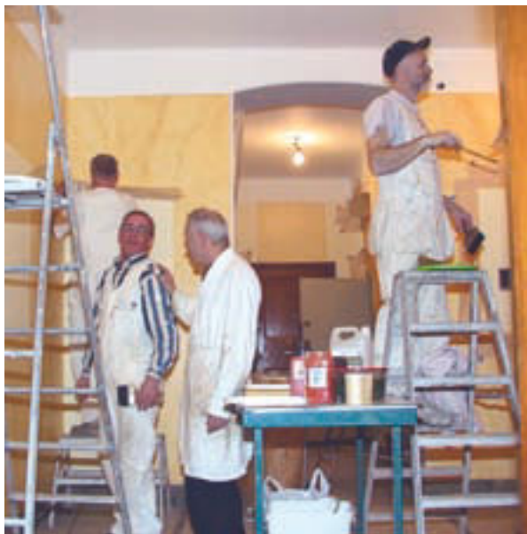
Trappentré på Kommendörsgatan i Stockholm där marmorering utfördes.
