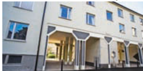
Återstäl-landet av flerbostadshusen på Östervägen i Södertälje har utsetts till Årets renovering.
