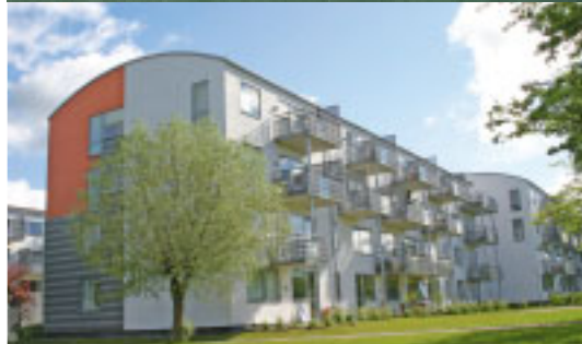
EFTER. Fyra våningar, varierande färger och välvda tak.
