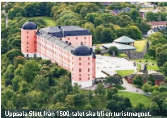
FOTO: STATENS FASTIGHETSVERK
