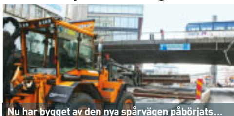
Nu har bygget av den nya spårvägen påbörjats...
