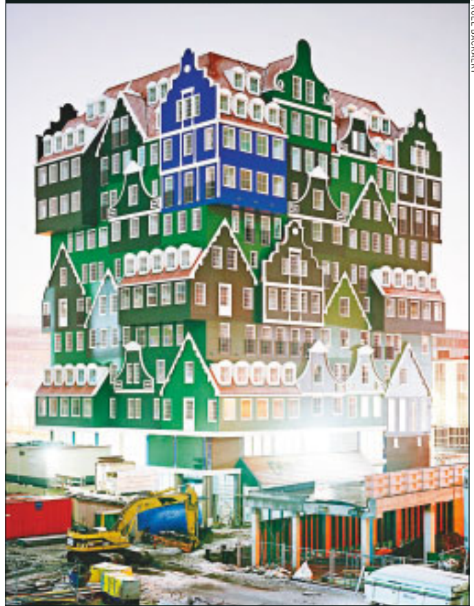
Utsikt mot nyligen invigda Inntel Hotels nordöstra gavel...
