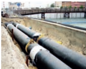
Fjärrvärmeutbyggnad i Malmö.
