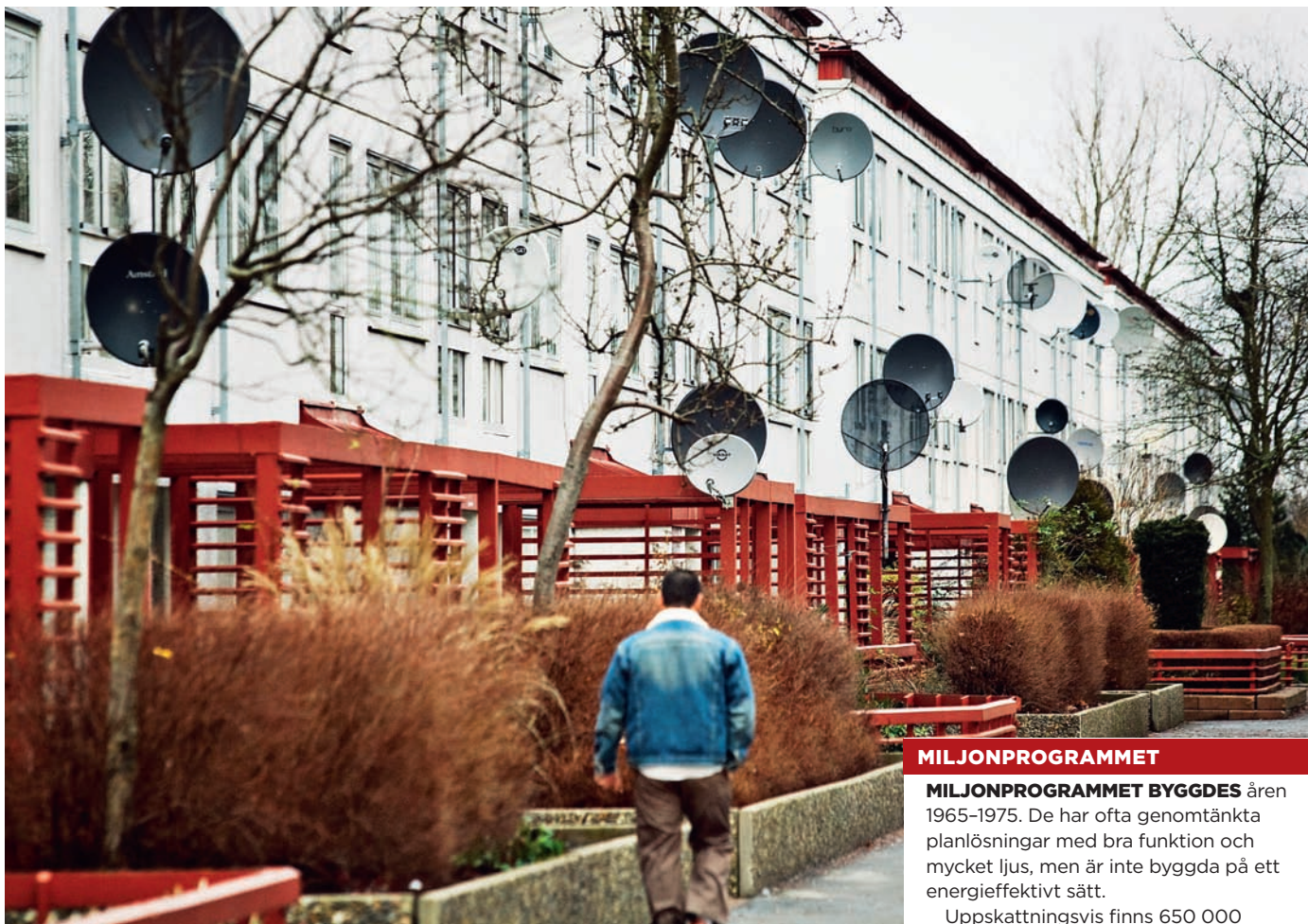
I stadsdelen Gårdsten utanför Göteborg – en del av miljonprogrammet – har omfattande energirenoveringar genomförts.
