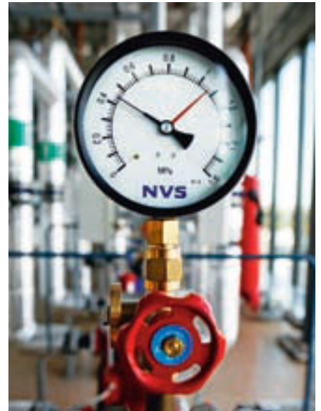
Energiförbrukningen i Kista Science Tower har minskat med 38 procent.
