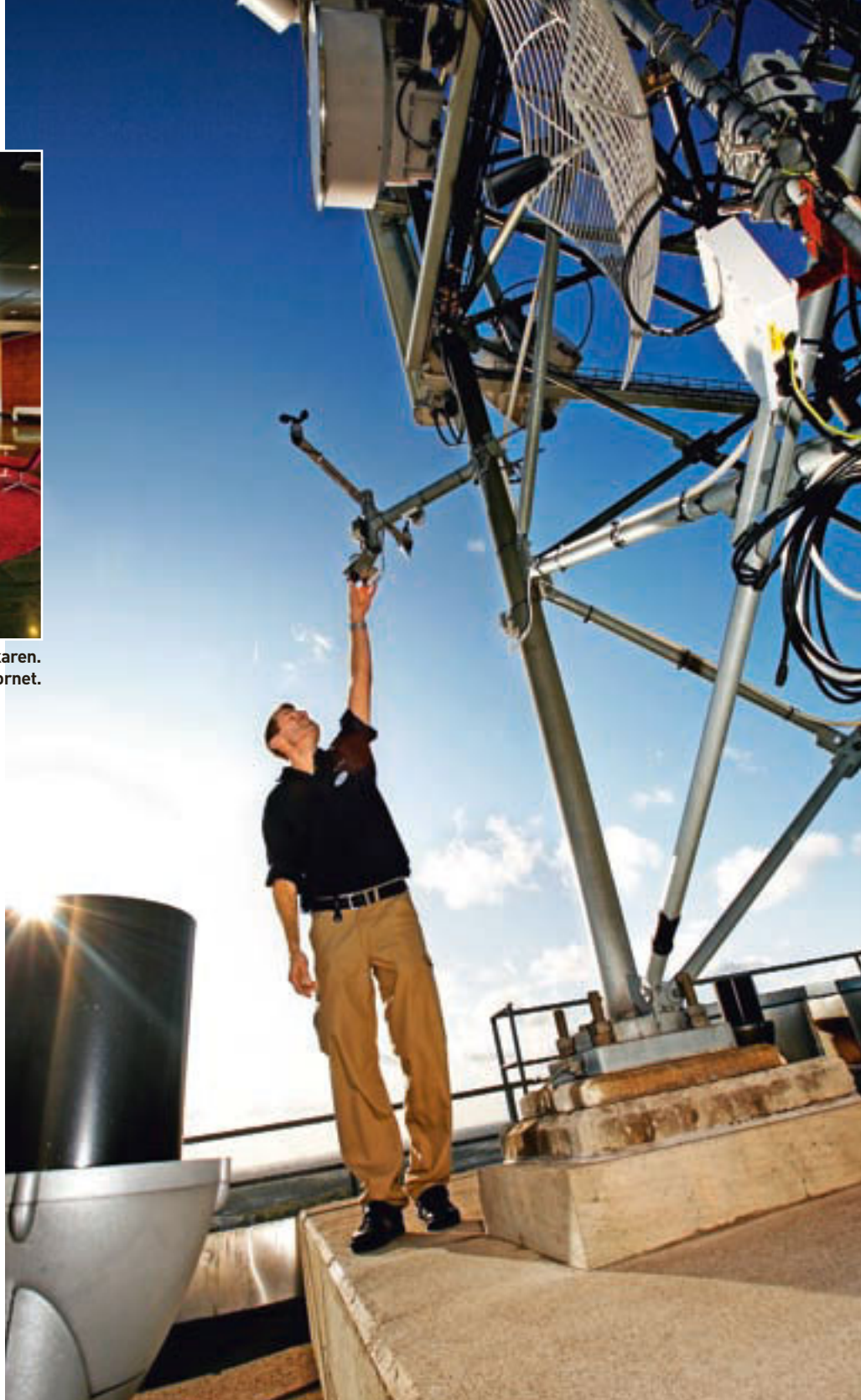
Dan Sellergren demonstrerar väderstationen på Kista Science Towers tak. Stationen mäter bland annat vindhastighet och soleffekt.
