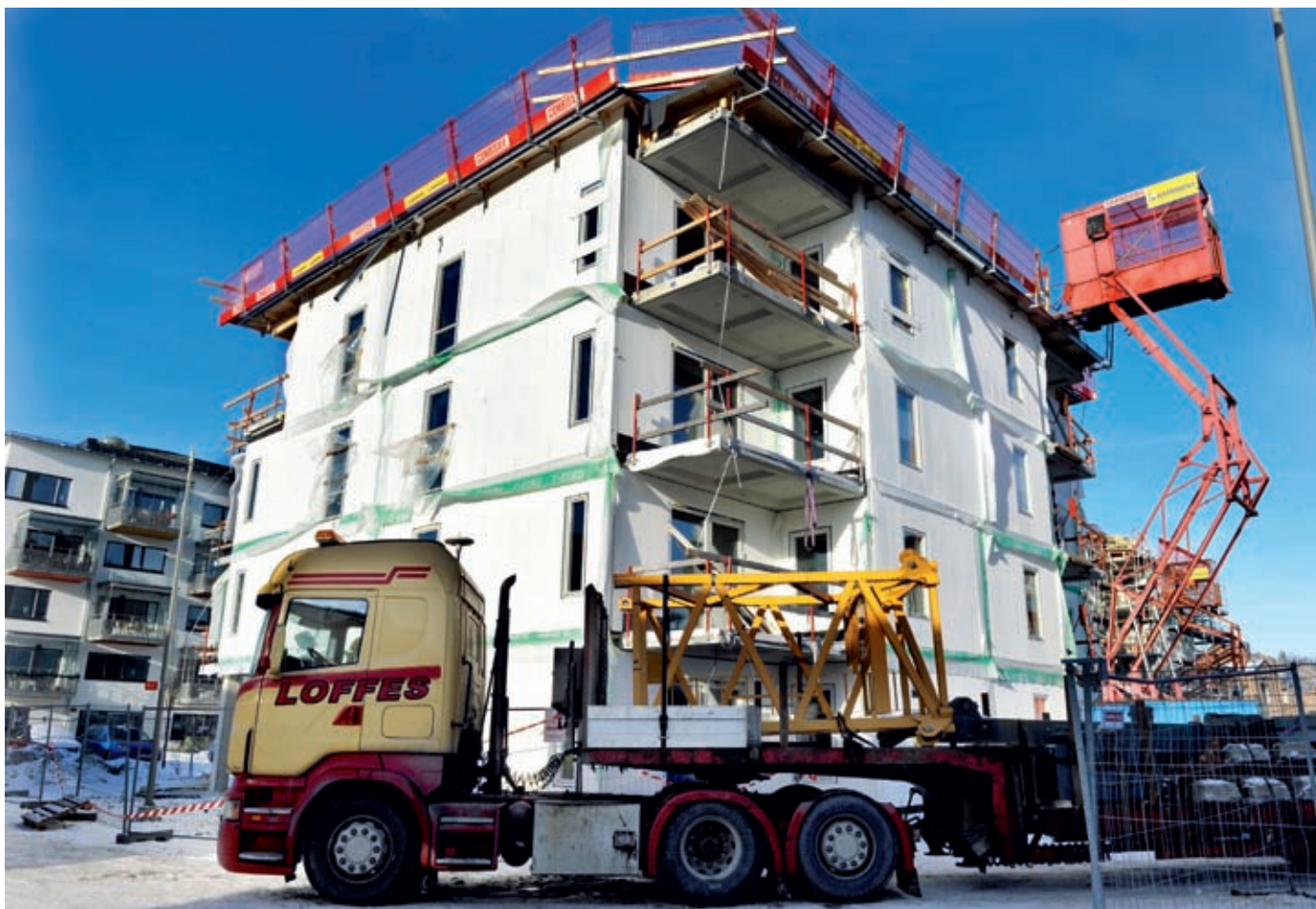
Transporter till och från byggen står för fem procent av alla växthusgaser i landet.
