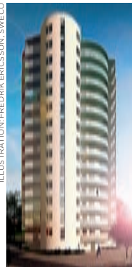
40 lägenheter blir det i silon.
