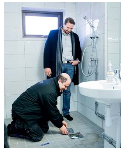
Stammarna behålls, men badrummen får helt nya tätskikt. Fastighetsköparen Patrik Krell och förvaltaren Mattias Lundborg kollar golvbrunnsmontage.
