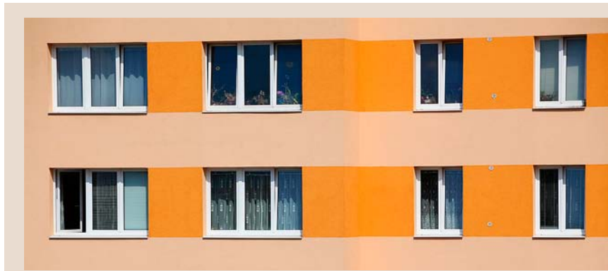
Vid riskbedömning måste man ta hänsyn till att regn på fasaden påverkar huset långt efter att det upphört.
